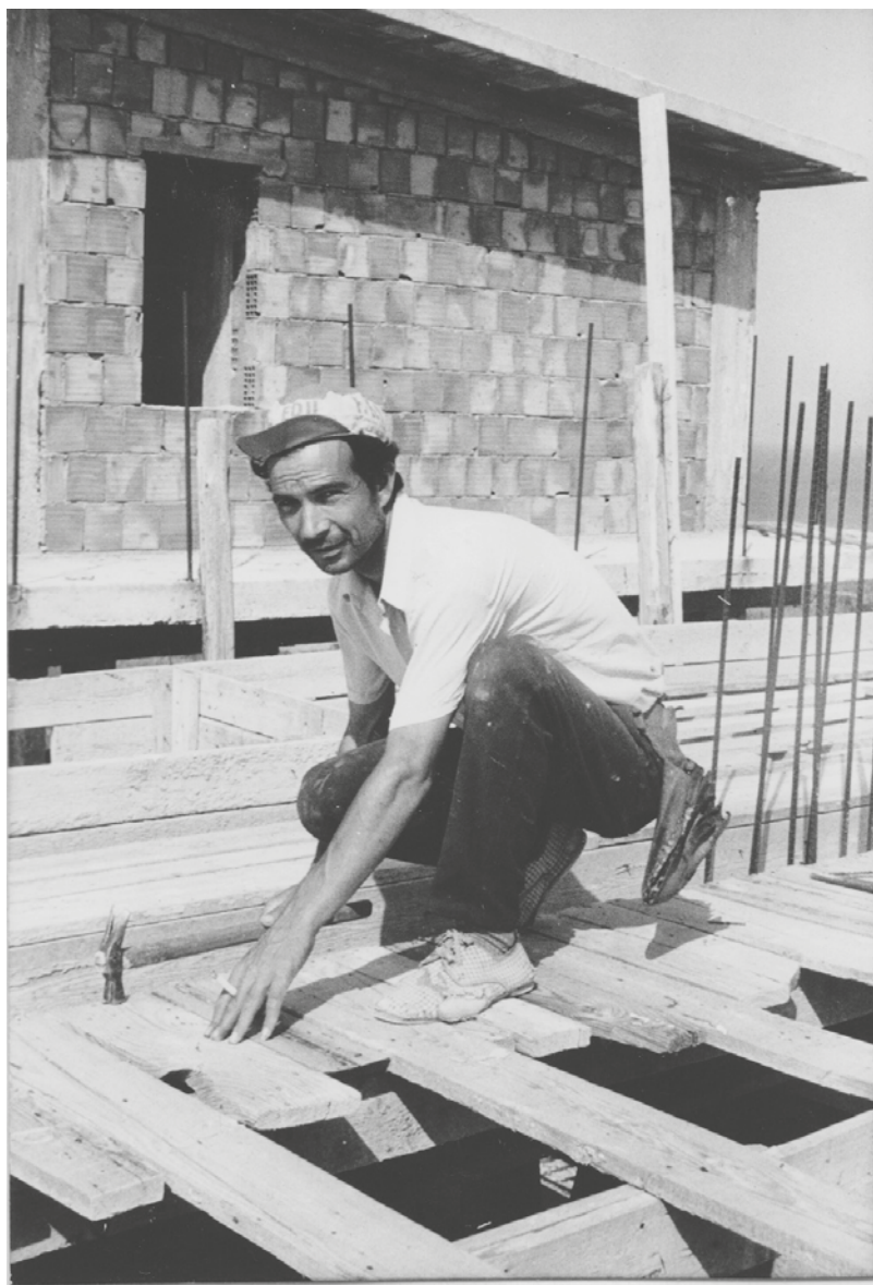
Qui mio cognato Nazzareno Bressi (1942-1981) falegname e carpentiere nel cantiere della costruenda sua casa in Via Nazionale, 130 a Badolato Marina (foto D. L. 1975).
